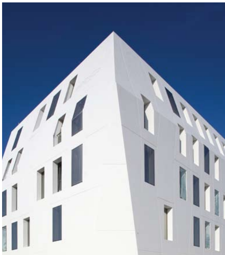
Seekoo Hotel (Bordeaux, France), design Atelier King Kong Architects (fachada do edifício realizada com DuPont™ Corian®); foto Arthur Pequin, todos os direitos reservados.
